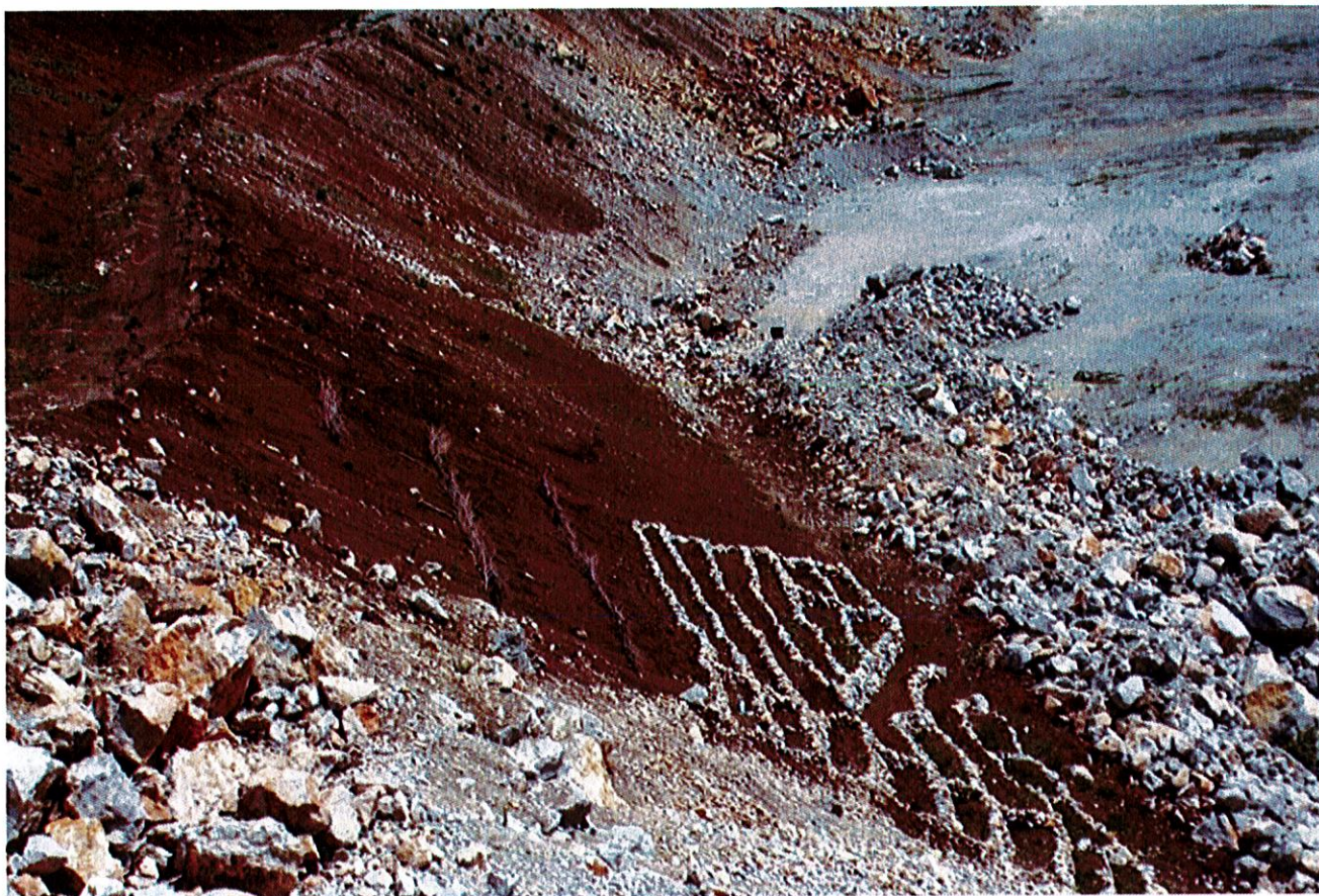
Figura 17. Cleionaje din material vegetal și anrocamente din piatră
