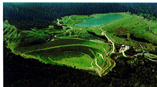
Figura 25. 2001 – etapa de restaurare ecologică
