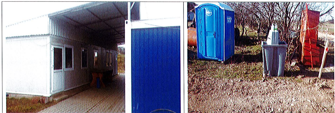
Figura 9. Model 10 organizare de șantier realizată din containere modulare (stânga) și model de amenajare a zonei sanitare, cu toaletă modulară cu bazin etanș, vidanjabil, tratat chimic, lavoar modular și pichet PSI
