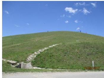
Imagine 7 Instalare sistem de drenaj și lucrări de recultivare în cadrul depozitului de deșeuri nepericuloase administrat de S.C. FCC ENVIRONMENT ROMANIA S.R.L.
