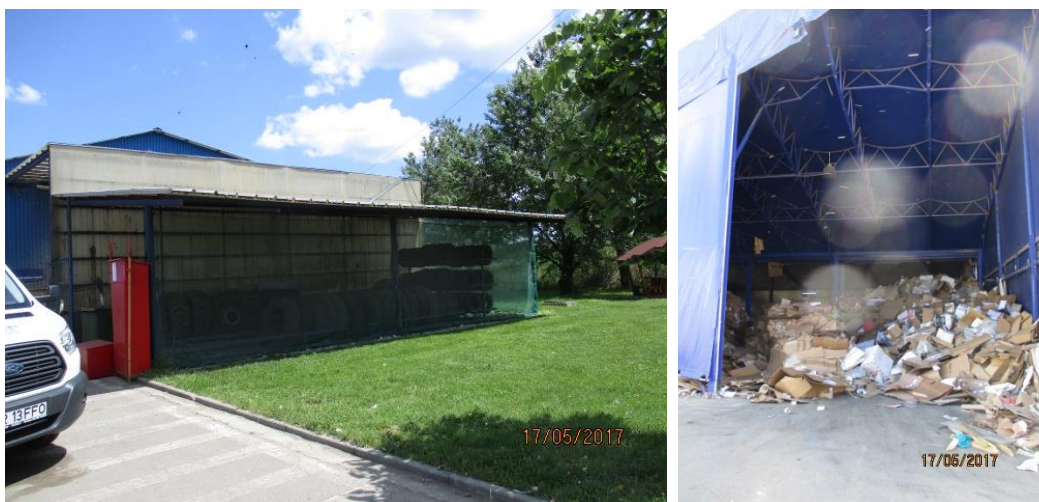
Imagine 5 Sopron depozitare anvelope și cort provizoriu pentru deseuri din hartie (intrare hala pentru valorificare materiale reciclabile)
