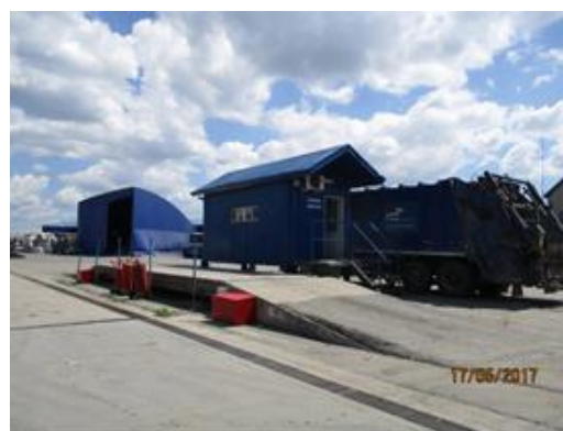
Imagine 2 Cabina cântar și platforma electronică de cântărire ce deservește depozitul de deșuri nepericuloase administrat de S.C. FCC ENVIRONMENT ROMANIA S.R.L.
