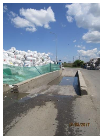
Imagine 3 Hala de spălare autovehicule, rampa de curățare și bazin spălare roți
