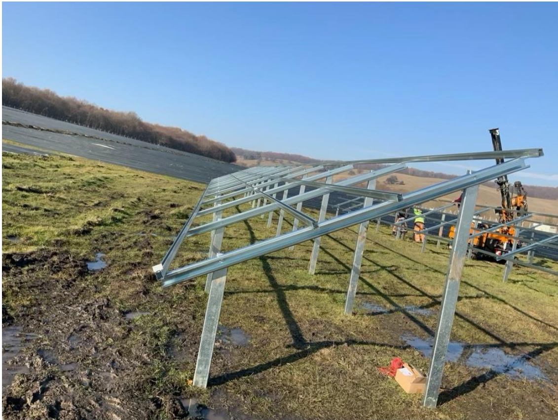
Exemplu de structura metalica pe sol
