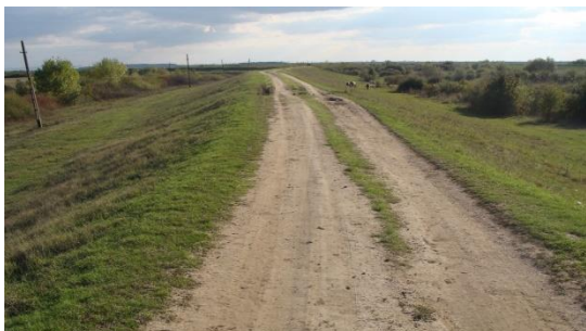
Coronamentul digului de contur și taluzul interior înierbat – la inspecția din anul 2020
