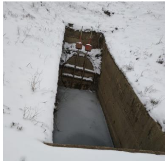
Golirea de fund de la compartimentul I și stăvilă de golire compartiment II – la inspecția din anul 2022
