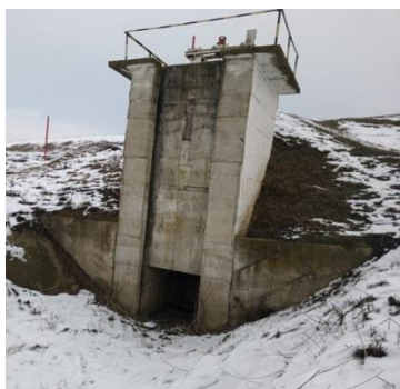
Turn de manevră și golirea de fund pentru compartimentul 1 – la inspecția din anul 2022
