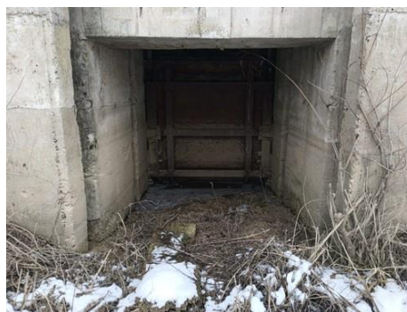
Turn de manevră și golirea de fund pentru compartimentul 1 – la inspecția din anul 2022
