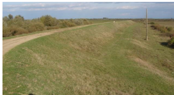
Coronamentul digului de contur și taluzul interior înierbat – la inspecția din anul 2020
