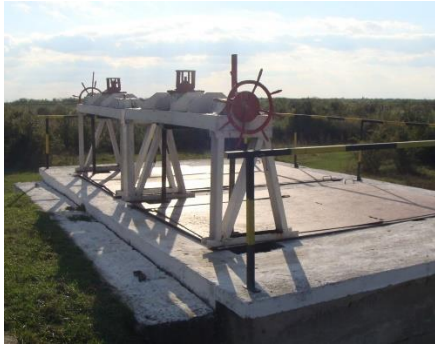
Mecanism de acționare stăvilă plane și conducte de evacuare din compartimentul II – la inspecția din ianuarie 2020
