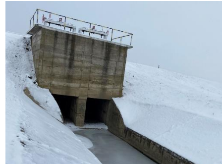
Golirea de fund de la compartimentul I și stăvilă de golire compartiment II – la inspecția din anul 2022
