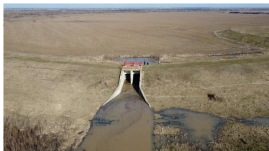
Golirea de evacuare a apelor din polder în p.Cigher
