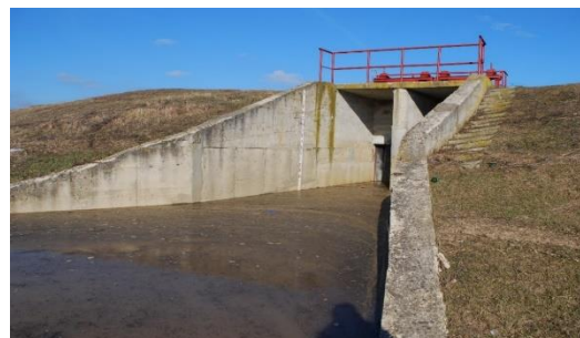
Golirea de evacuare a apelor din polder în p.Cigher
