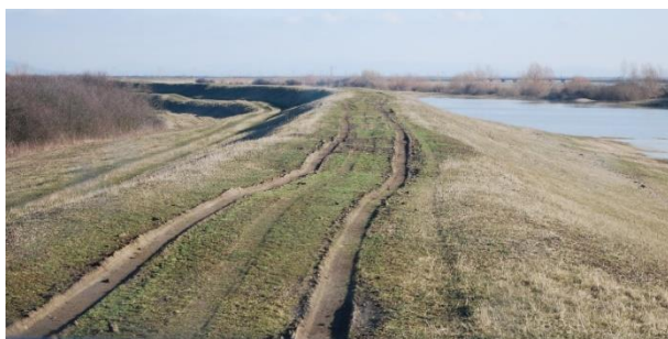
Denivelări, tasări ale cotei coronamentului digului și mușuroaie
