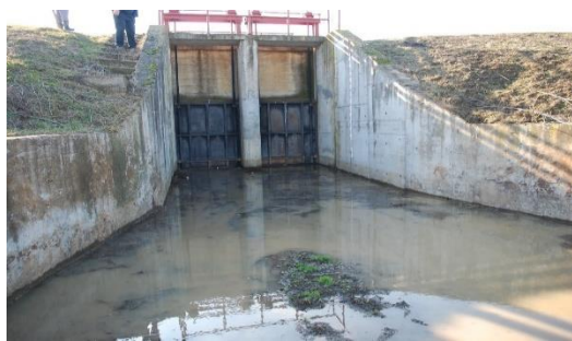
Stavilele golirii de fund și mecanismele de acționare ale acestora
