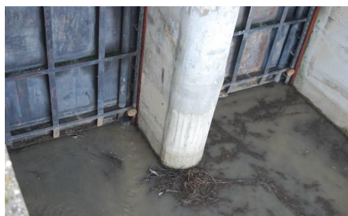
Stavilele golirii de fund și mecanismele de acționare ale acestora
