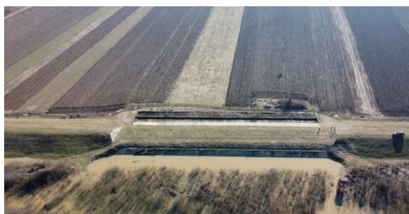
Deversorul de acces al apei în polder cu disipatorul și râul Crișul Alb în zona acestuia, cu secțiuna albiei acoperită cu vegetație
