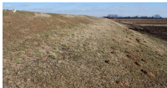
Denivelări, tasări ale cotei coronamentului digului și mușuroaie
