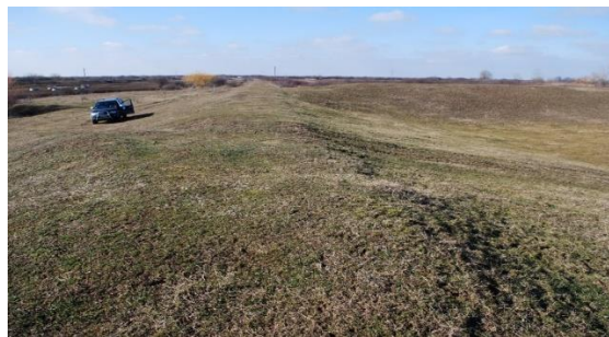
Denivelări și tasări ale cotei coronamentului digului
