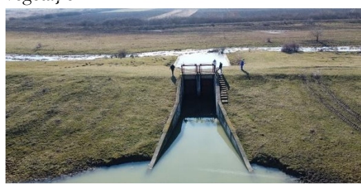
Golirea de evacuare a apelor din polder în pârâul Gut
