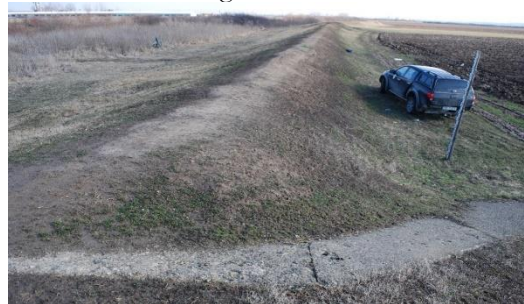
Deversorul de acces al apei în polder fără disipator și râul Crișul Alb în zona acestuia, cu secțiunea albiei acoperită cu vegetație
