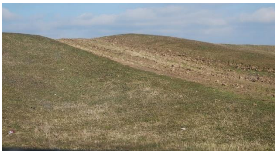
Denivelări și tasări ale cotei coronamentului digului
