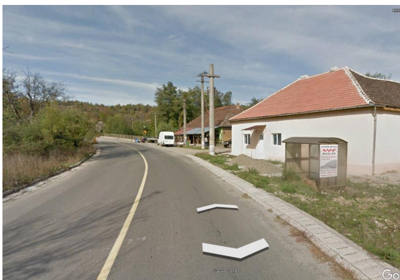
Figura nr. 68 - Amenajarea scurgerii apelor, dar lipsa amenajărilor privind deplasările pietonale și amenajarea stațiilor de transport intrajudețean, DN 76 – Aluniș.
