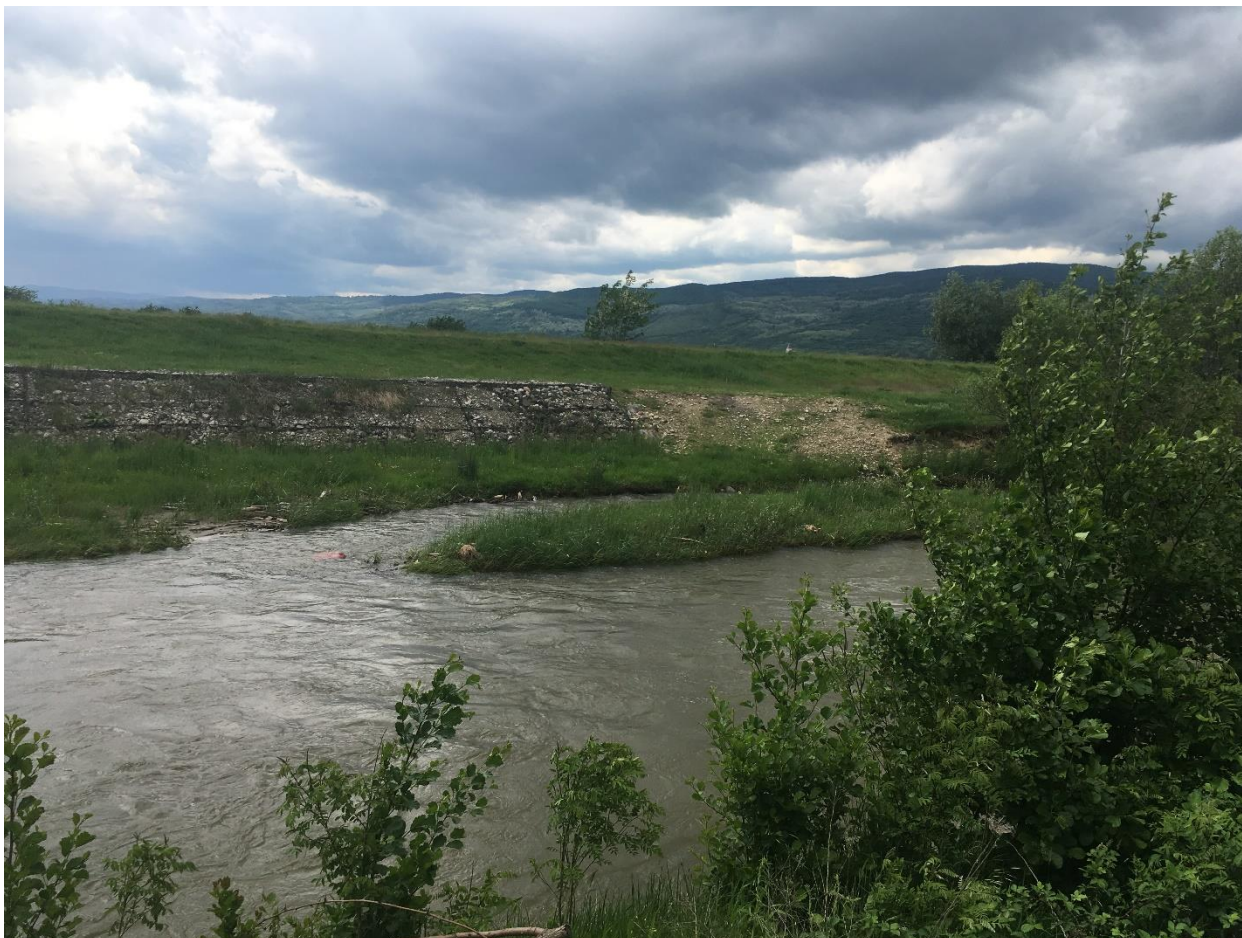
Figură 17 - Aspect al lucrărilor existente de pe râul Cugir
