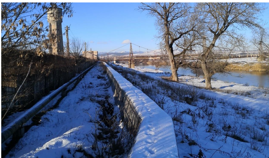
Figură 14 - Aspect al parapetului existent
