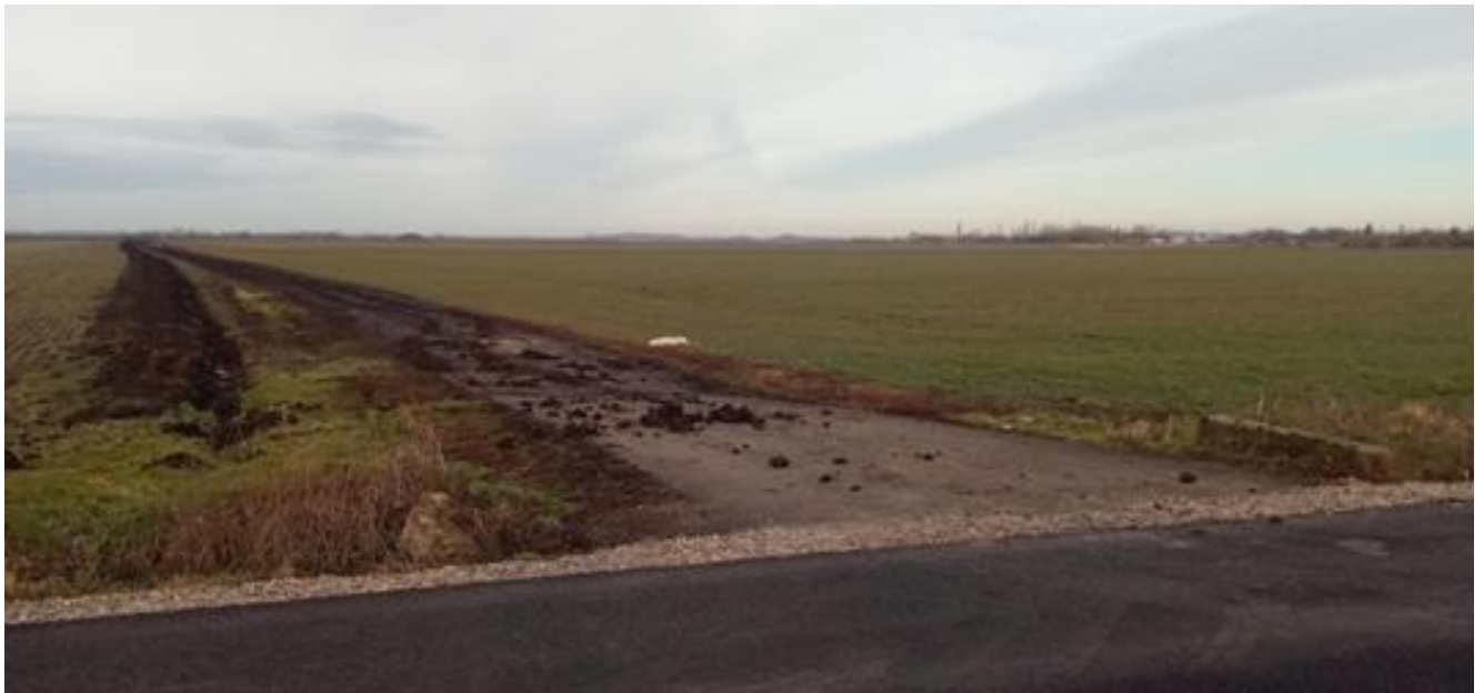
Imagine cu intersectia dintre drumul judetean secundar DJ 709 J Curtici – Pecica si drumul de exploatare De 333 (zona racord) ( realizarea accesului la sonda face obiectul altui proiect).
