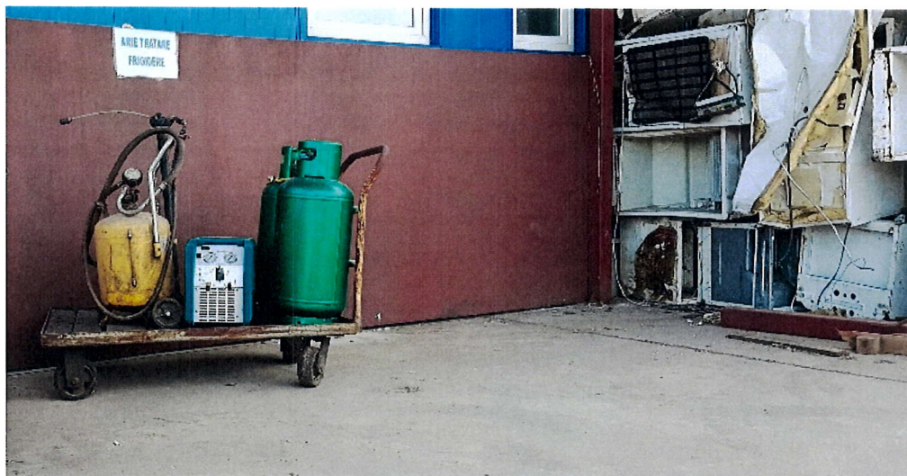
Fig.1 Instalatie eliminare gaz/Lichide
