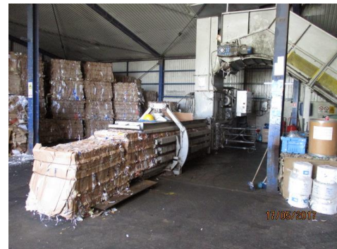
Poza 9 Presa balotat
