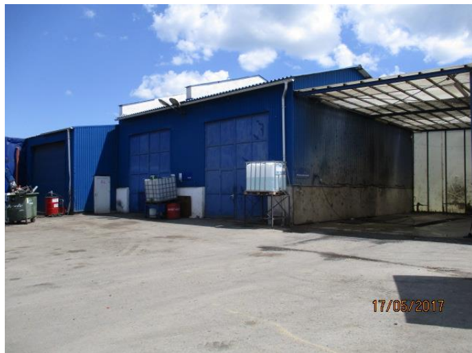
Poza 7 Hala spalare
