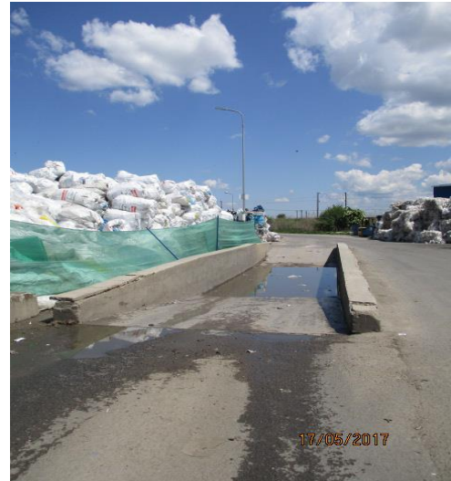
Poza 8 Rampa de curatare si bazin spalare roti
