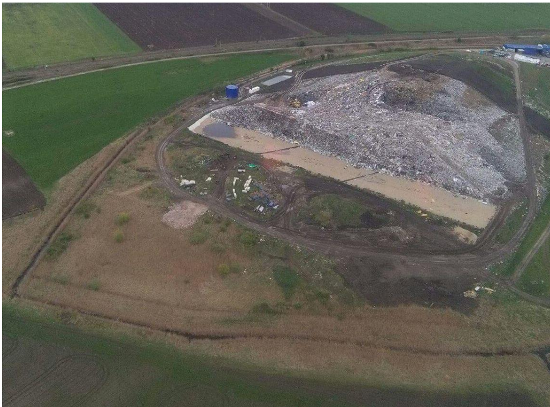
Poza 1 Imagine de ansamblu sectoare depozitare deseuri ASA
