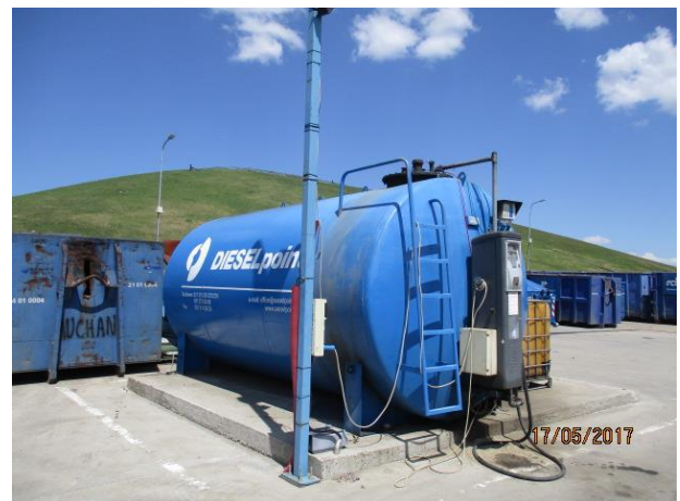
Poza 12 Statie alimentare combustibili
